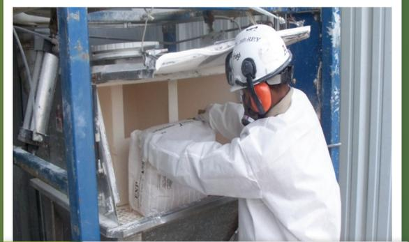
**3** Drehen Sie den Sack so, dass die aufgeschnittene Seite nach unten zeigt und entleeren Sie ihn.
