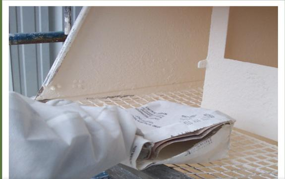
**6** Rollen Sie den leeren Sack nahe an der Belüftungsöffnung auf, um die noch darin enthaltene Luft herauszudrücken.
