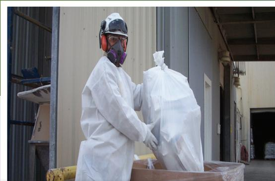
**8** Wenn der Entsorgungssack voll ist, verschließen und versiegeln Sie ihn und legen den Sack in einen Versandbehälter zur fachgerechten Entsorgung, wie zum Beispiel zur Verbrennung oder zur Endlagerung auf einer überwachten Deponie.
